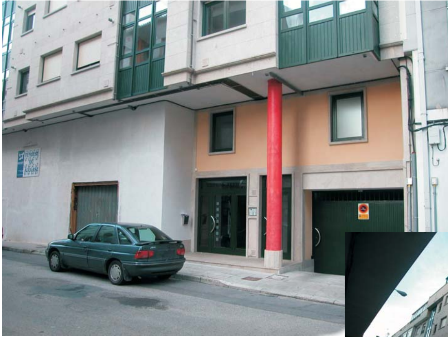
FACHADA EDIFICIO FERRO
